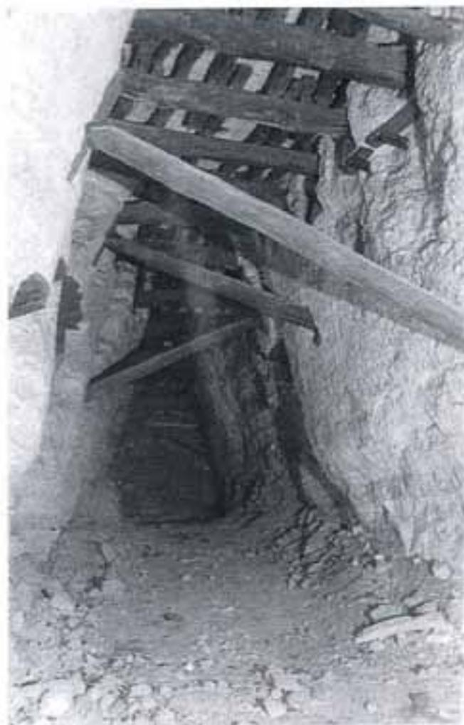
*Fig.13 Boisage en ciel de carrière. Ils étaient installés au moyen de palans, de poulies, de cordages et de nœuds de cabestan. Cette photo montre bien le soutien du ciel de carrière grâce au « petits » et aux « pièces ».*
