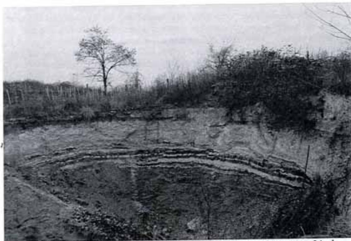
Fig.8 Fontis au-dessus d'une carrière de gypse de première masse. L'arbre donne une idée de l'importance de l'excavation.
