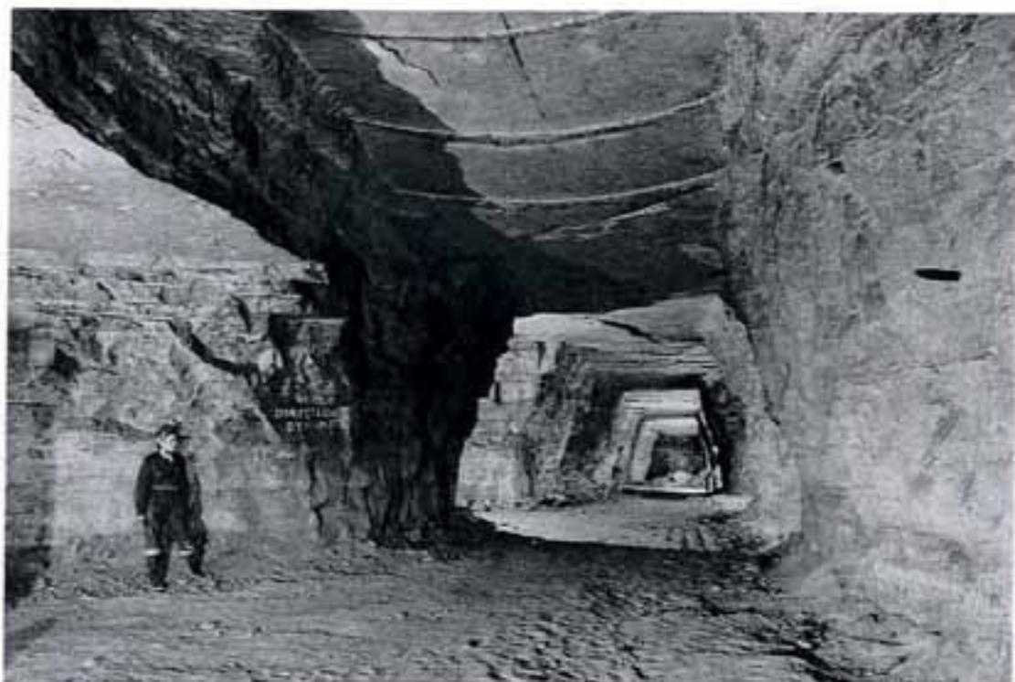
Fig.10 Galerie de seconde masse. La forme trapézoïdale de ce type d'exploitation se rencontrait dans les carrières Lafarge aujourd'hui remblayées (Photo Francis CAHUZAC).
